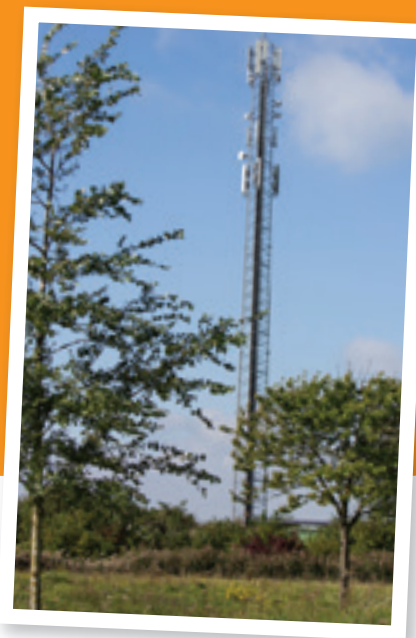
➤ Zendmast op een parkeerplaats.
