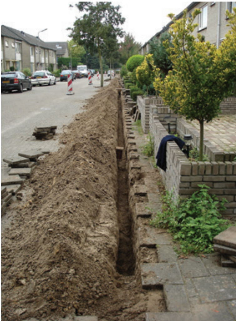
▲ Een sleuf aan het Lijndje in Mierlo.
